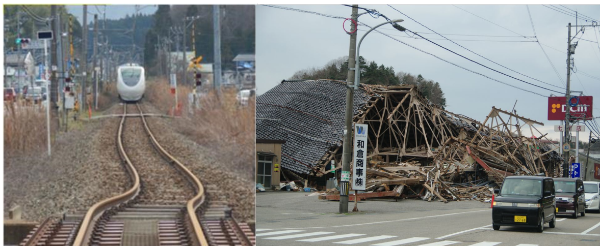
Slika 4: Levo: Ukrivljena železniška proga med postajama Nanao in Wakuraonsen; Desno: Porušeno skladišče v Nanau (Wikipedia, 2025b).
